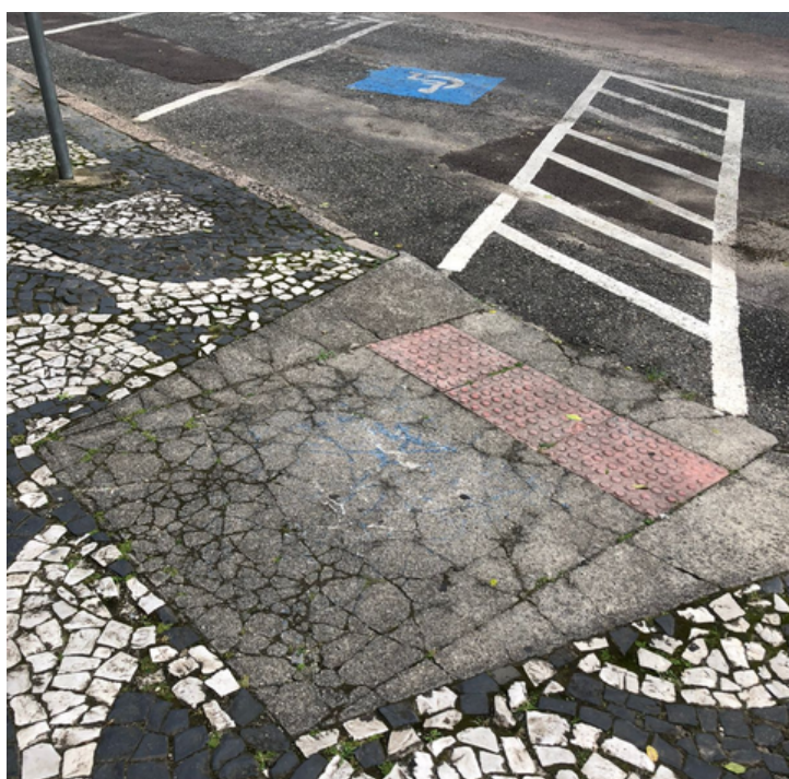
Rampa de acesso próxima a vaga destinada a PCD.
